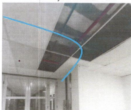
Tramo de bandeja a instalar 10m.
