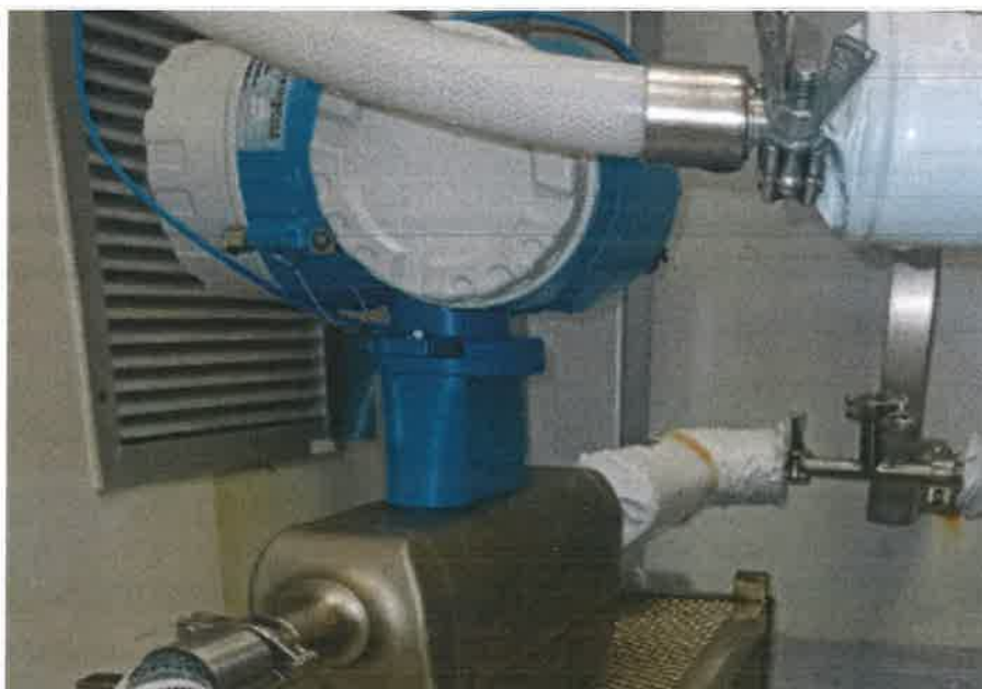
CAUDALIMETRO ACTUAL INSTALADO, PROMASS P ENDRESS+HAUSER DN 15, 3/4" CLAMP
