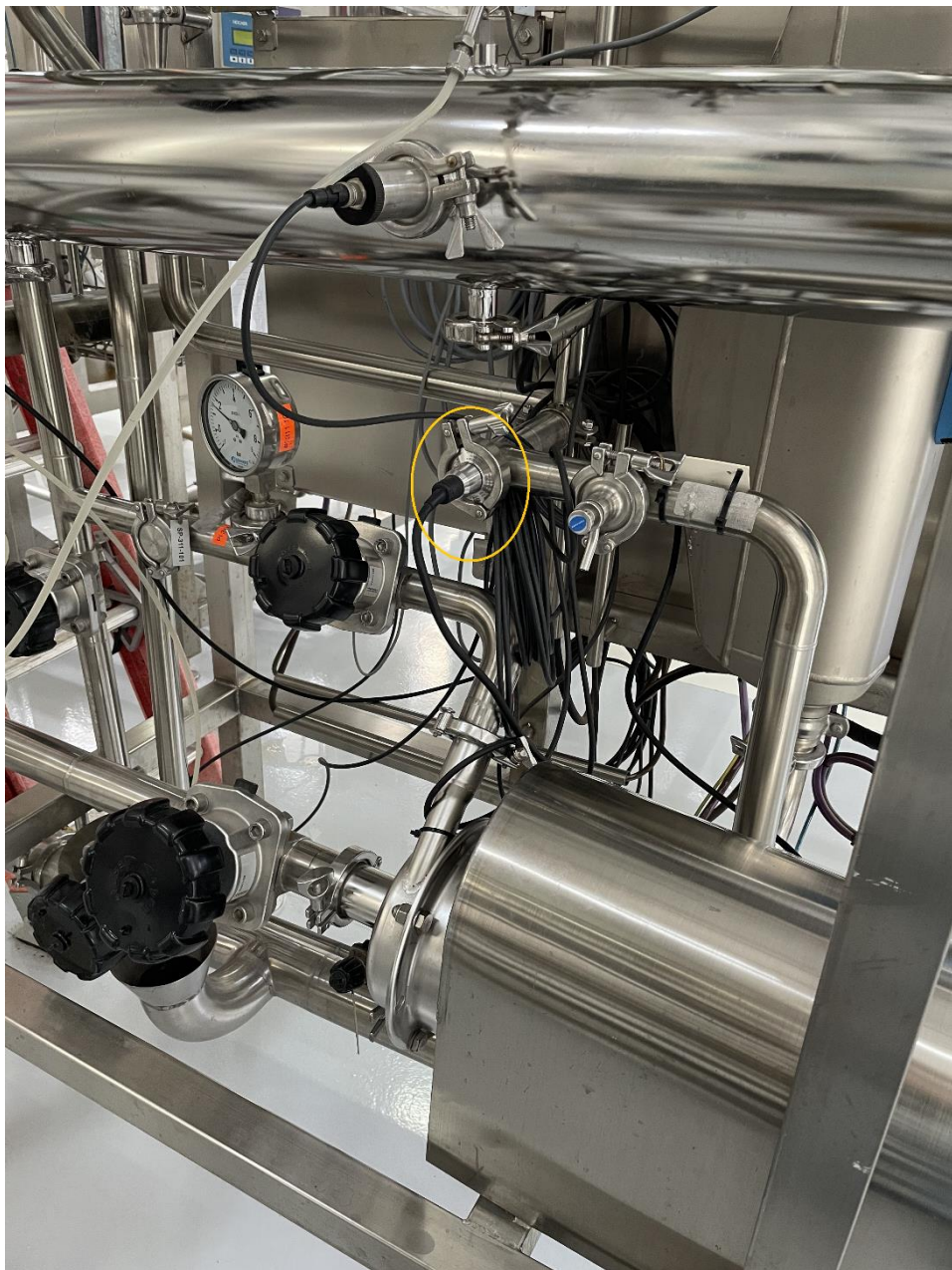
Imagen 1: Disposición para celda de conductividad en Skid de distribución de PW a Formulación Final I (loop AO 10.2).
