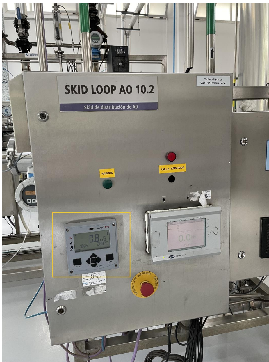
Imagen 2: Disposición para controlador electrónico en Skid de distribución de PW a Formulación Final I (loop AO 10.2).
